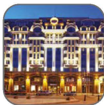
Защита высотных домов и гостиничных комплексов
